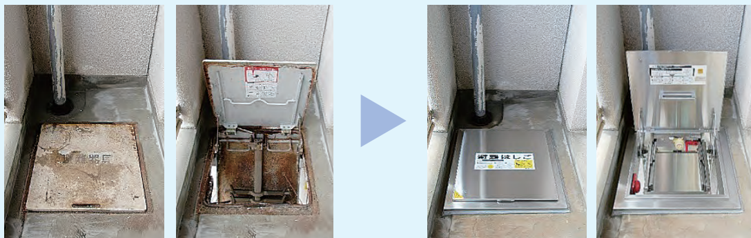
錆など腐食が進んだ避難はしごの交換
