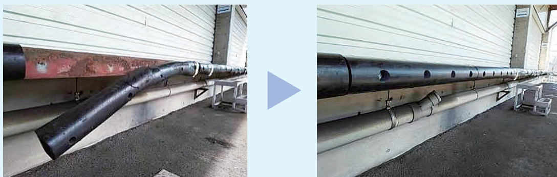
老朽化、破損したストッパーゴムの交換
