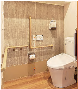
トイレ補助手摺
